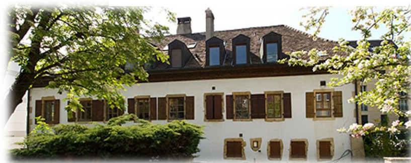
Bâtiment 04 Laboratoire Multimédia LMM
