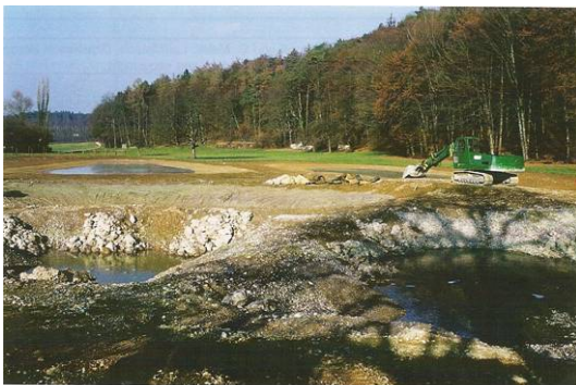
Bau des Lehmweihers (Bildmitte). Vorn zwei grosse Folienweiher, hinten zwei Flachtümpel mit Kalkstabilitätsabdichtung. (Foto: C. Meier)
