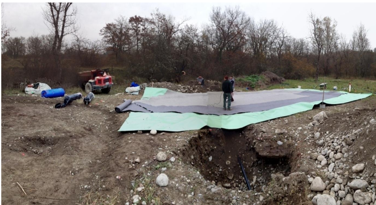
Vue panoramique du chantier : au premier plan, la fosse drainante (qui sera par la suite comblée) dans laquelle arrive l'extrémité du tuyau PVC de vidange ; au second plan, installation de la triple couche « géotextile-bâche type Sarnafil-géotextile » ; sur la gauche, une seconde bassière pourvue d'une sur-creuse a déjà été aménagée en vue d'accueillir un plan d'eau similaire.
