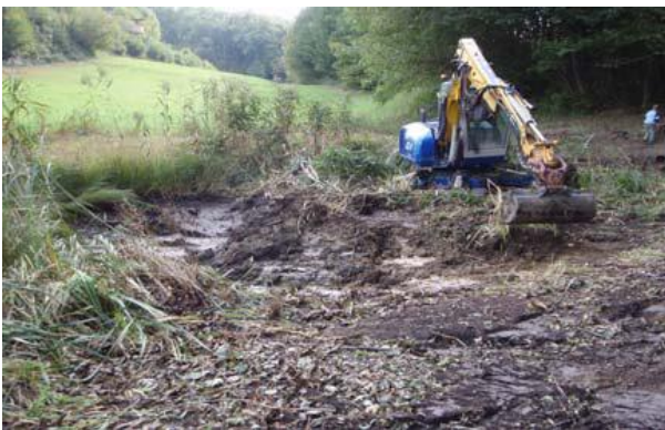
Ausbaggern eines Gewässers in einer Senke am Waldrand, die natürlicherweise vernässend ist.
