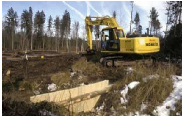
Das Aufstauen von Entwässerungsgräben ermöglicht das Entstehen eines grossen Gewässers mit minimalen Kosten.
