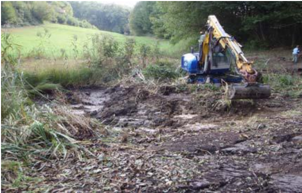
Creuse d'un plan d'eau dans une dépression naturellement humide en lisière forestière.
