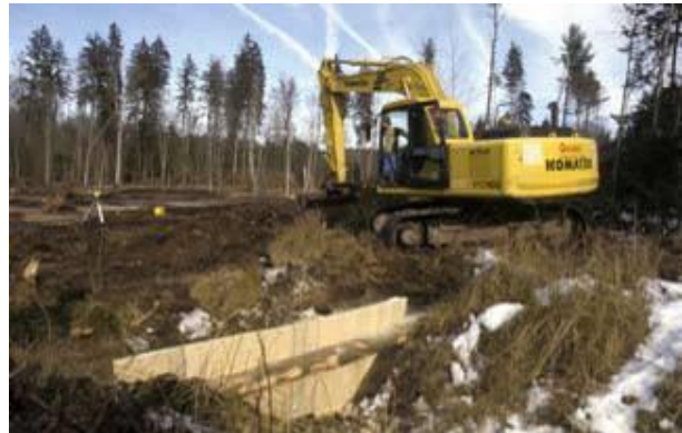
La mise en place de barrages le long des fossés de drainage permet de créer de vastes plans d'eau à moindre coût.
