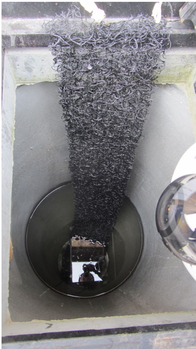
Krallmatte in Entwässerungsschacht montiert
