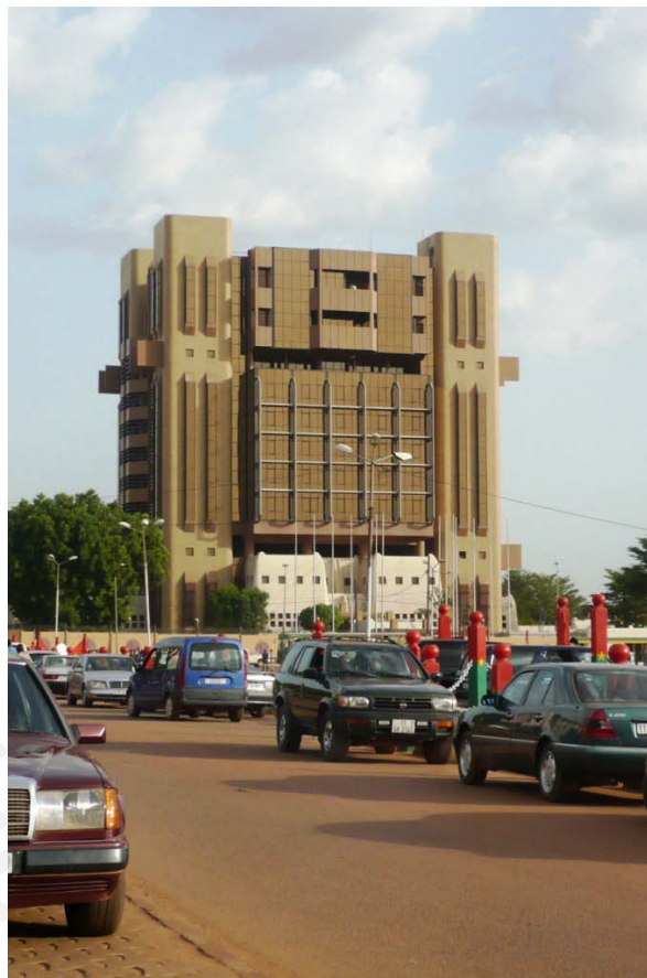
Figure 3 : La BCEAO, premier « gratte-ciel » du centre de Ouagadougou construit en 1991 70
