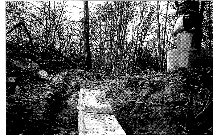
Abbildung 2: Einstiegsgang aus vorfabrizierten Haubenkanälen (© Oekovision GmbH, 8967 Widen). Figure 2: Galerie d'entrée du terrier composée d'éléments préfabriqués quadrangulaires (© Oekovision GmbH, 8967 Widen).
