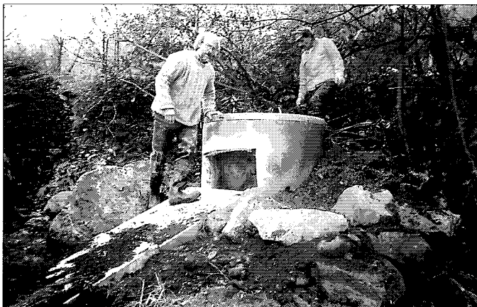
Abbildung 5: Sicht auf einen fertigen Biberbau kurz vor der Überdeckung mit Erdmaterial. Die Wohnkammer besteht aus einem abgelegten Betonrohr. Der Einstieg befindet sich unter den Bruchsteinen.
